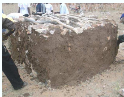
4. Les pierres sont stabilisées avec le mélange de banco, de la bouse de vache et de l'huile de vidange
