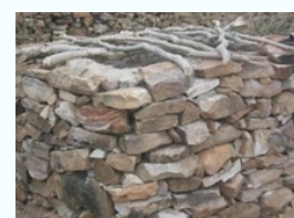
Construction du trou de latrine en zone plateau
