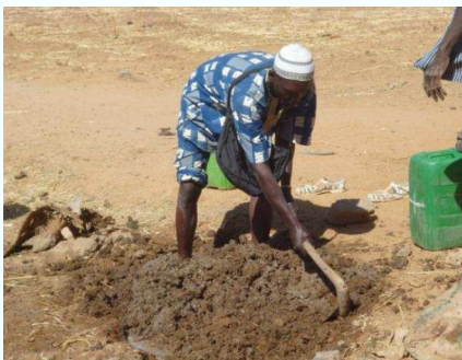
4. Un mélange de banco avec la bouse de vache est préparé pour couvrir la fosse.
