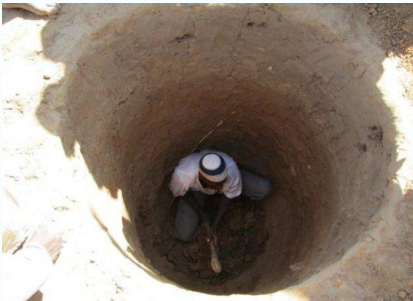
1. Le maçon creuse le trou de la latrine.
