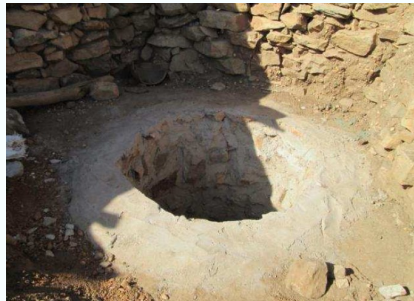
2. Le trou est stabilisé avec des pierres taillées par les maçons locaux.
