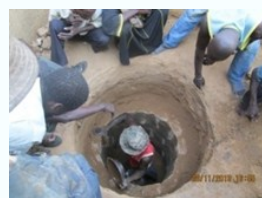
Stabiliser de paroi en zone sablonneuse
