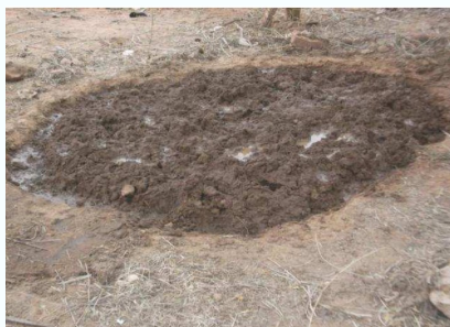
2. Un mélange de banco renforcé par la bouse de vache et de l'huile de vidange est préparé
