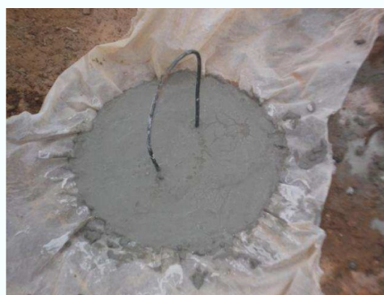
7. Le couvercle du trou de défécation est confectionné avec du ciment mélangé avec du sable.
