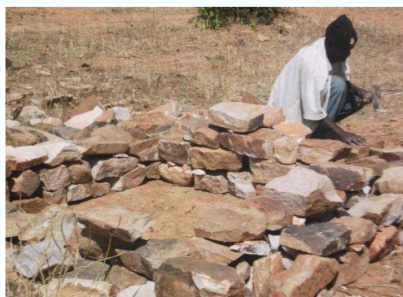
1. Le maçon taille des pierres pour construire la latrine
