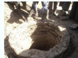
Construction du trou de latrines en zone
