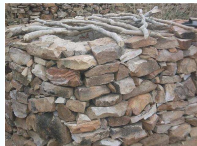
3. Après avoir monté les pierres, la latrine est couverte de bois.
